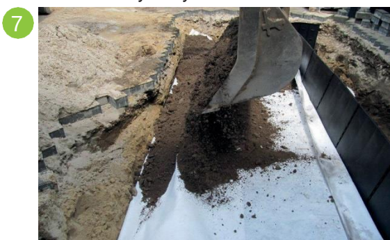
Položte geotextilii a zaplňte smíšeným granulátem
