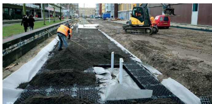
Instalace systému SandwichBox
