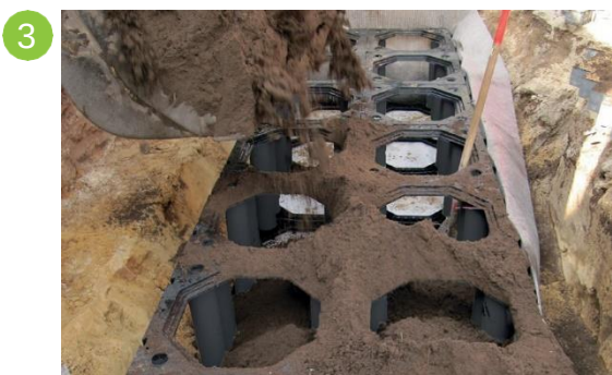
Zaplňte systém bioretenční půdou / půdou pro stromové buňky
