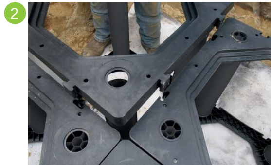
Připojte sloupky a horní rámy
