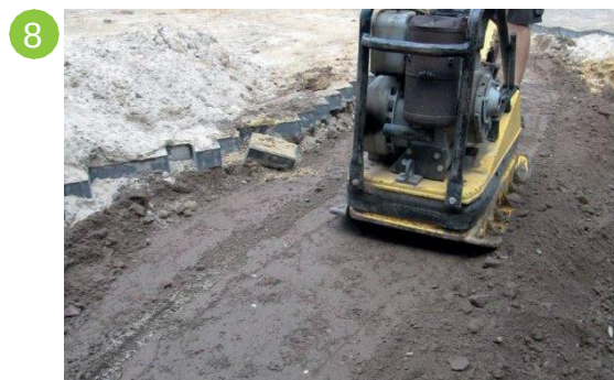
Vibračně zhutněte, proveďte zpevněný povrch, hotovo!
