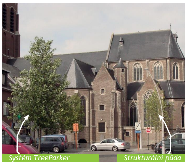
2 roky po instalaci
